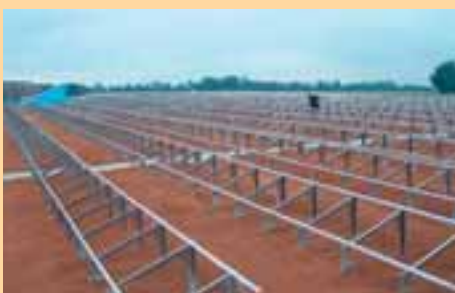
Entsprechend der notwendigen Auflast werden die Solarbasis®-Platten mit Systemerde überdeckt.
