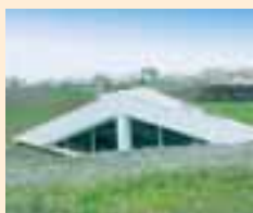
Störungen wie Kamine, Lüfter, Lichtkuppeln, technische Aufbauten usw.
