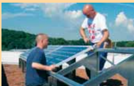
Die Solarpanels werden montiert.
