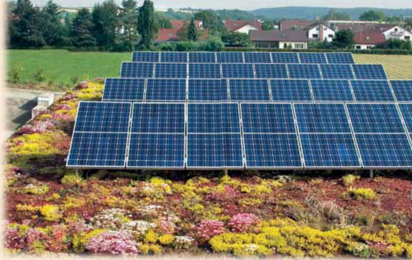
Dach der Firma Pro Natur in Metzingen
