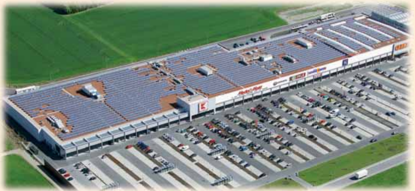
Photovoltaik-Anlage auf dem InCenter in Landsberg/Lech nach der Fertigstellung
