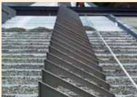
Kopplung der Anlage mit Aluprofilen z. B. bei einem Standort mit Windzone 2 und Zuschlag „Küste“ und ungünstigen baulichen Voraussetzungen.
