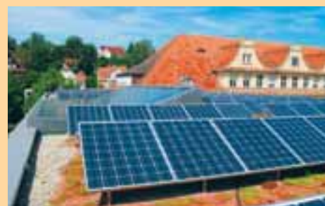
Das Dach mit Solaranlage nach der Fertigstellung.
